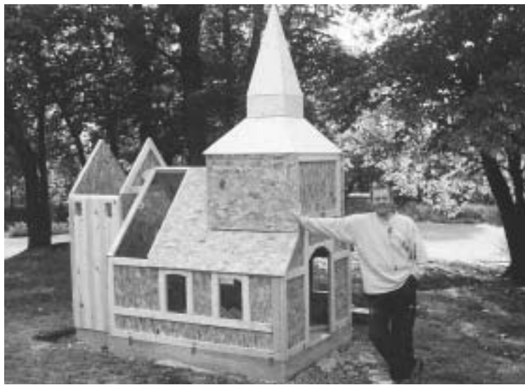
Tornet rest och taket halvvägs lagt. Byggmästare Claes Edman och de andra hantverkarna jobbar på lillkyrkan var ledig stund. Sedan är det målarnas tur. Under oktober hoppas man på invigning.
